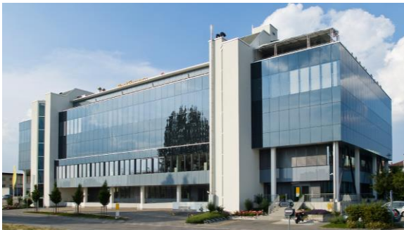
Fassadenansicht Rechenzentrum Zofingen
